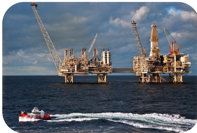
海上作业平台
