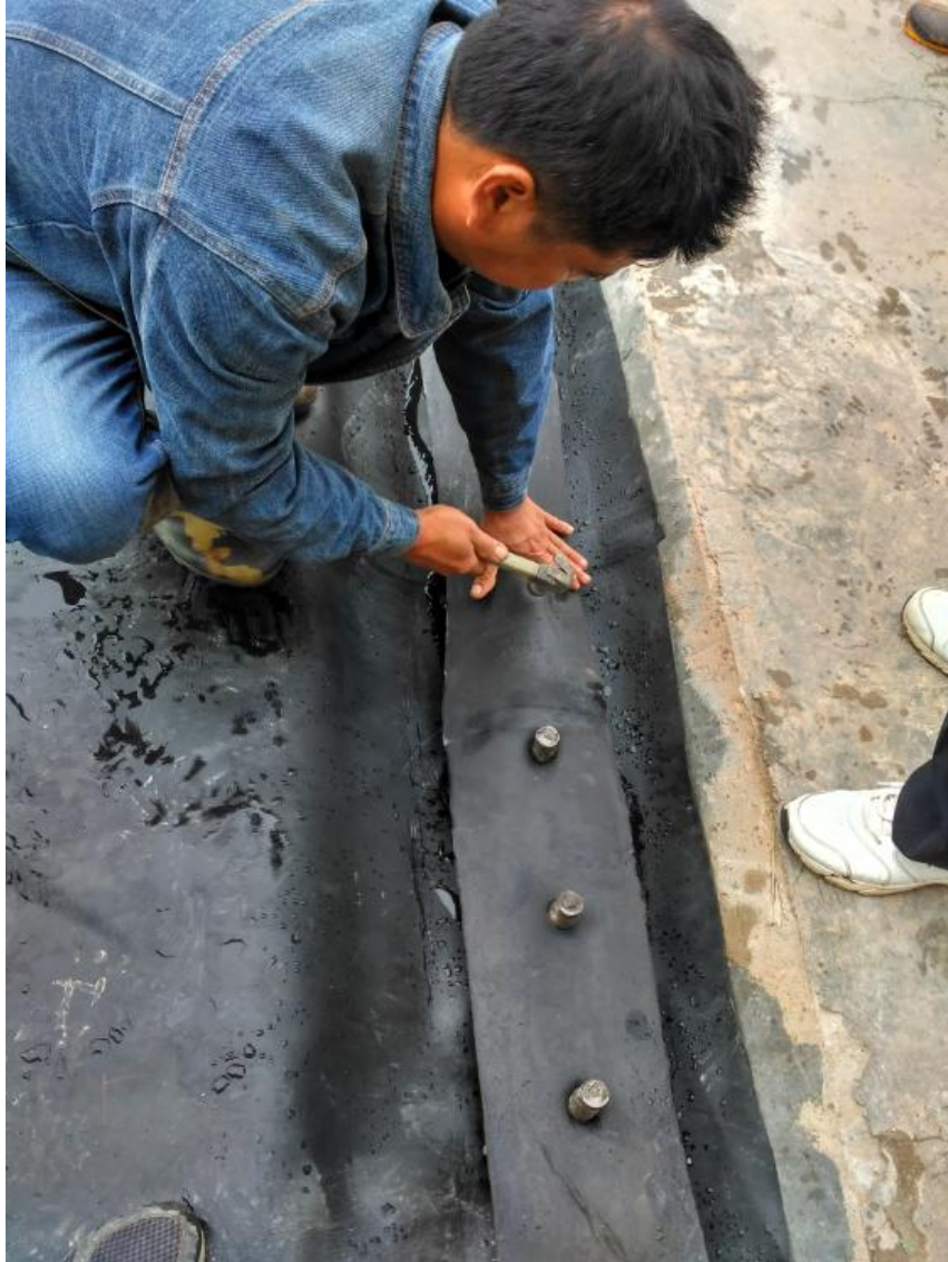
铺装止水海绵
