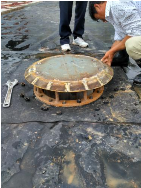
进排水口带水帽的上法兰
