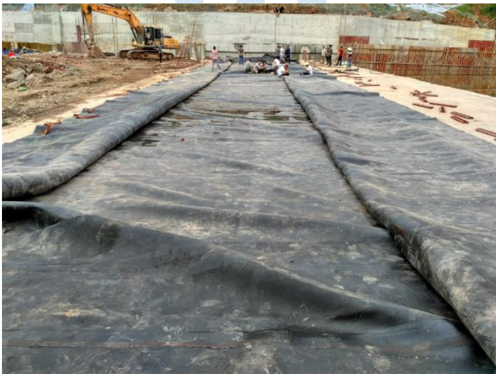
坝体折叠完成
