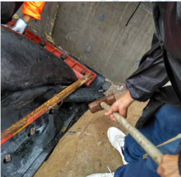
上压板压实，螺栓入孔
