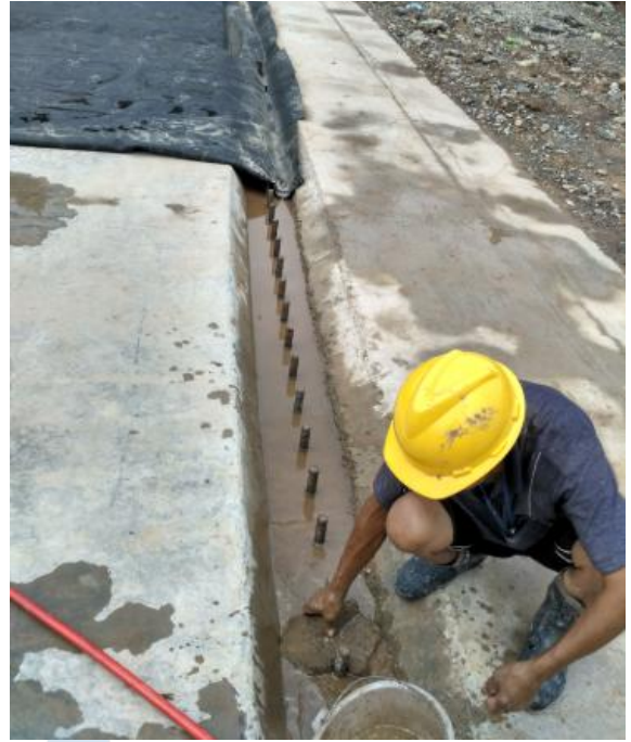
基础清理-海绵吸水，清掉泥沙
