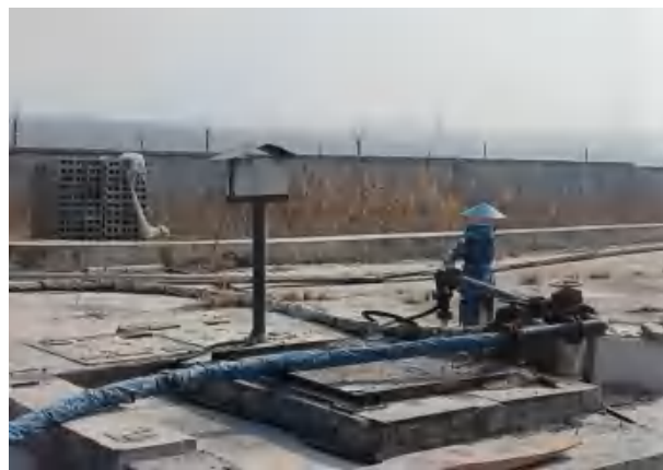
附图9 厂区雨水排放口
