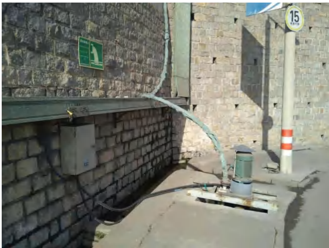
复合肥生产雨水排放口
