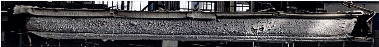
图片 2 耐火试验结束时构件情况
