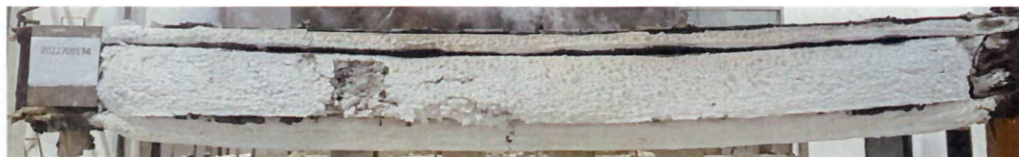
照片 2 耐火试验结束时试件情况
