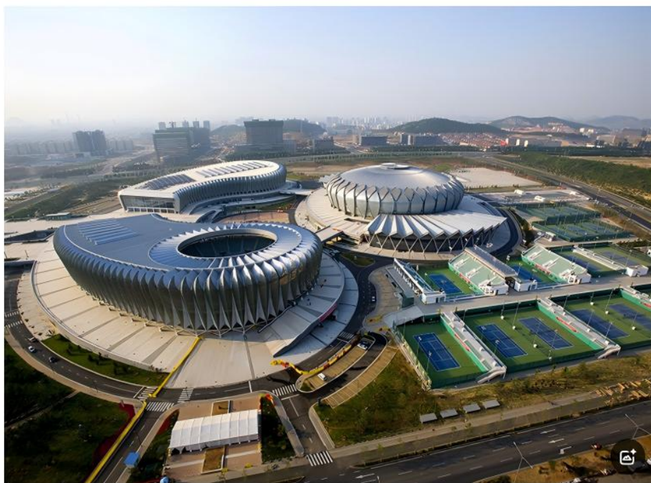
济南奥林匹克体育中心网球馆（鲁班奖）
