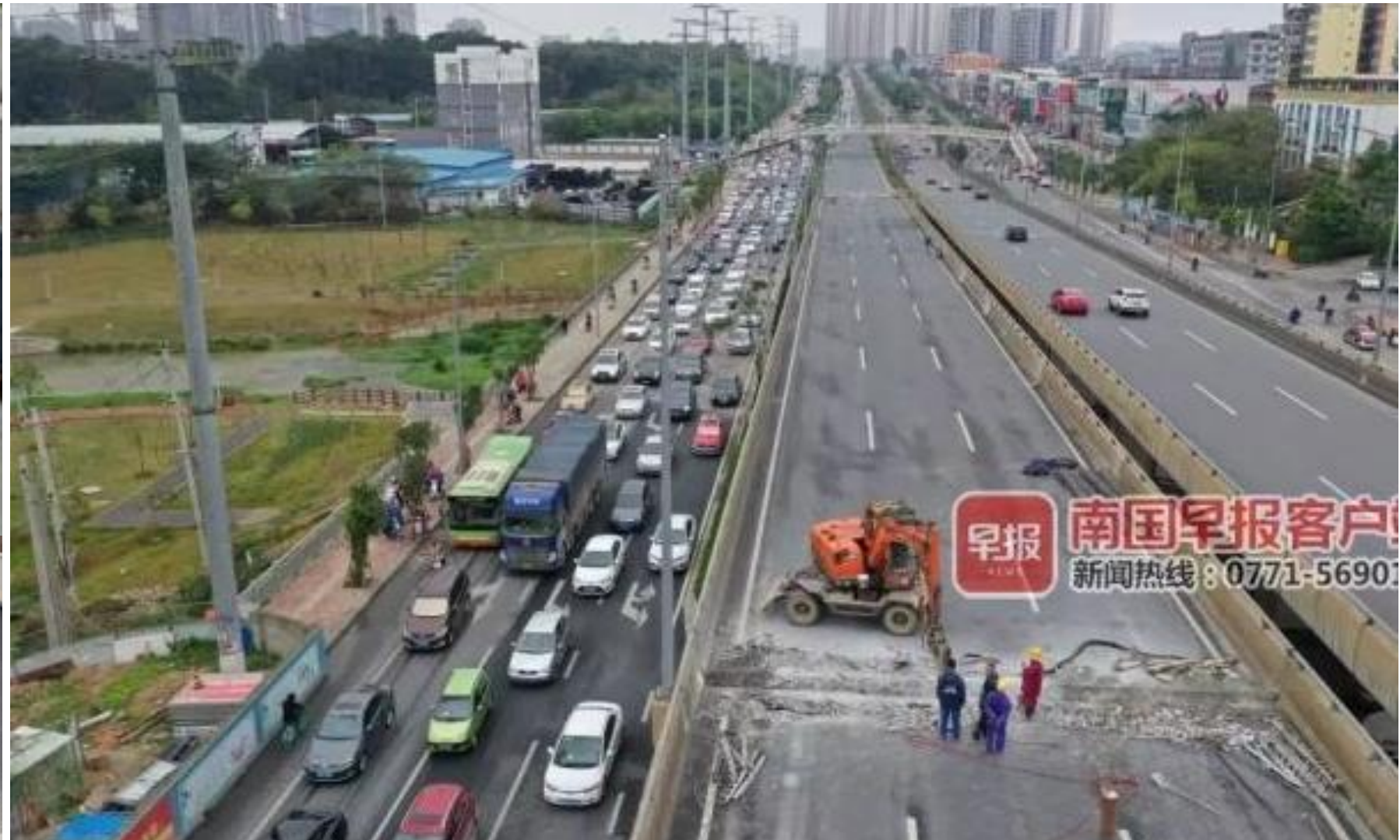
南宁秀厢大道沙江立交伸缩缝维修养护施工，早高峰时段，拥堵路段的车辆排起了数公里长龙，晚高峰时段，交通压力仍十分明显，通行十分缓慢。
