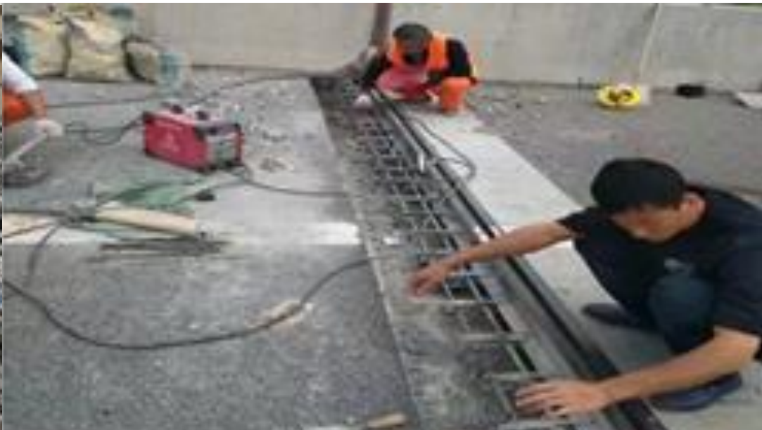
安装伸缩缝装置
