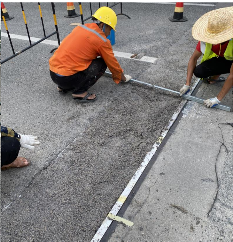
南方区域：海南环岛高速、三亚市政桥梁伸缩缝修复
