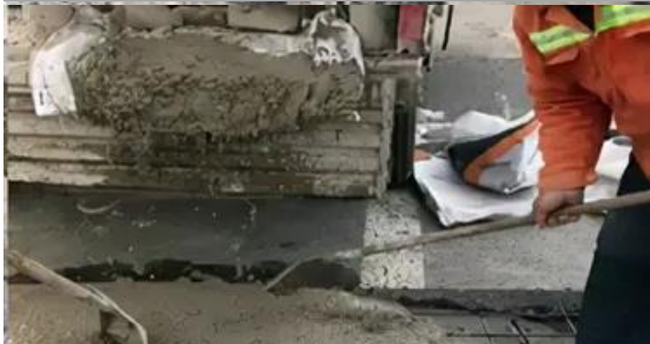
模板安装、浇筑混凝土
