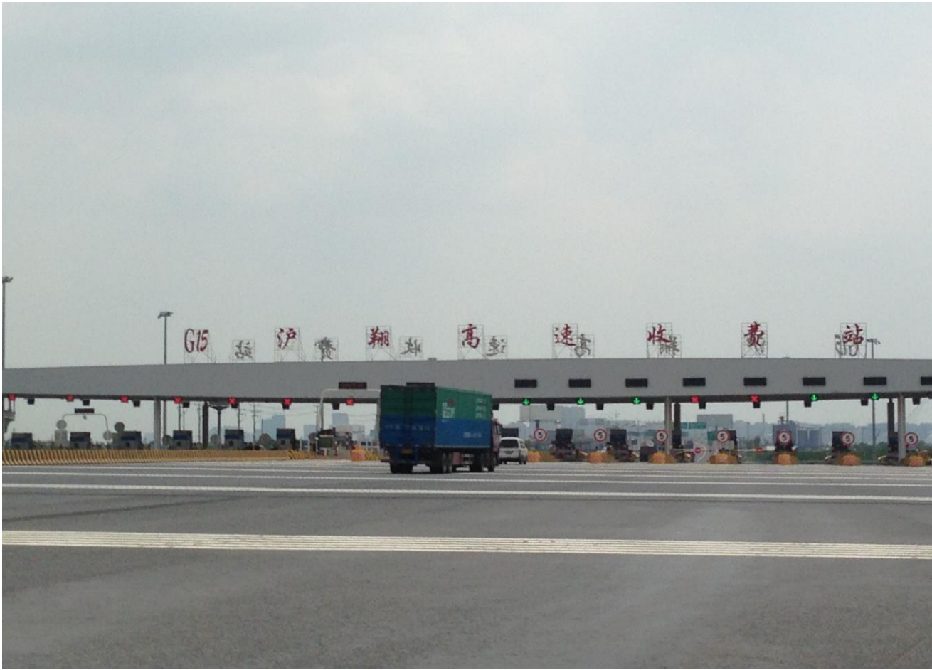
东部区域：上海外环、城市高架伸缩缝新建与维修
