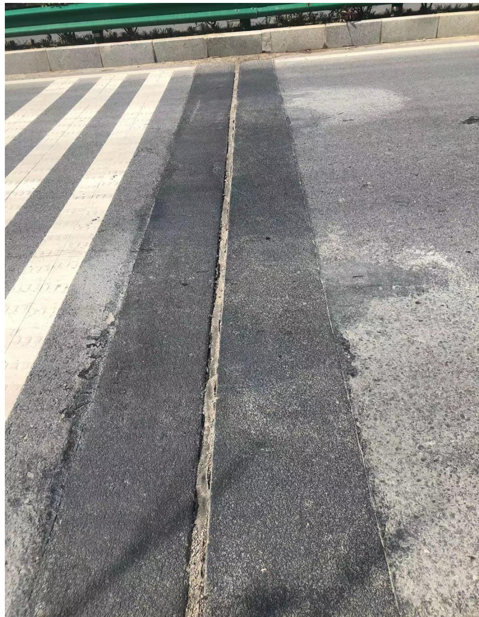
S108免型钢伸缩缝 二年后实拍
