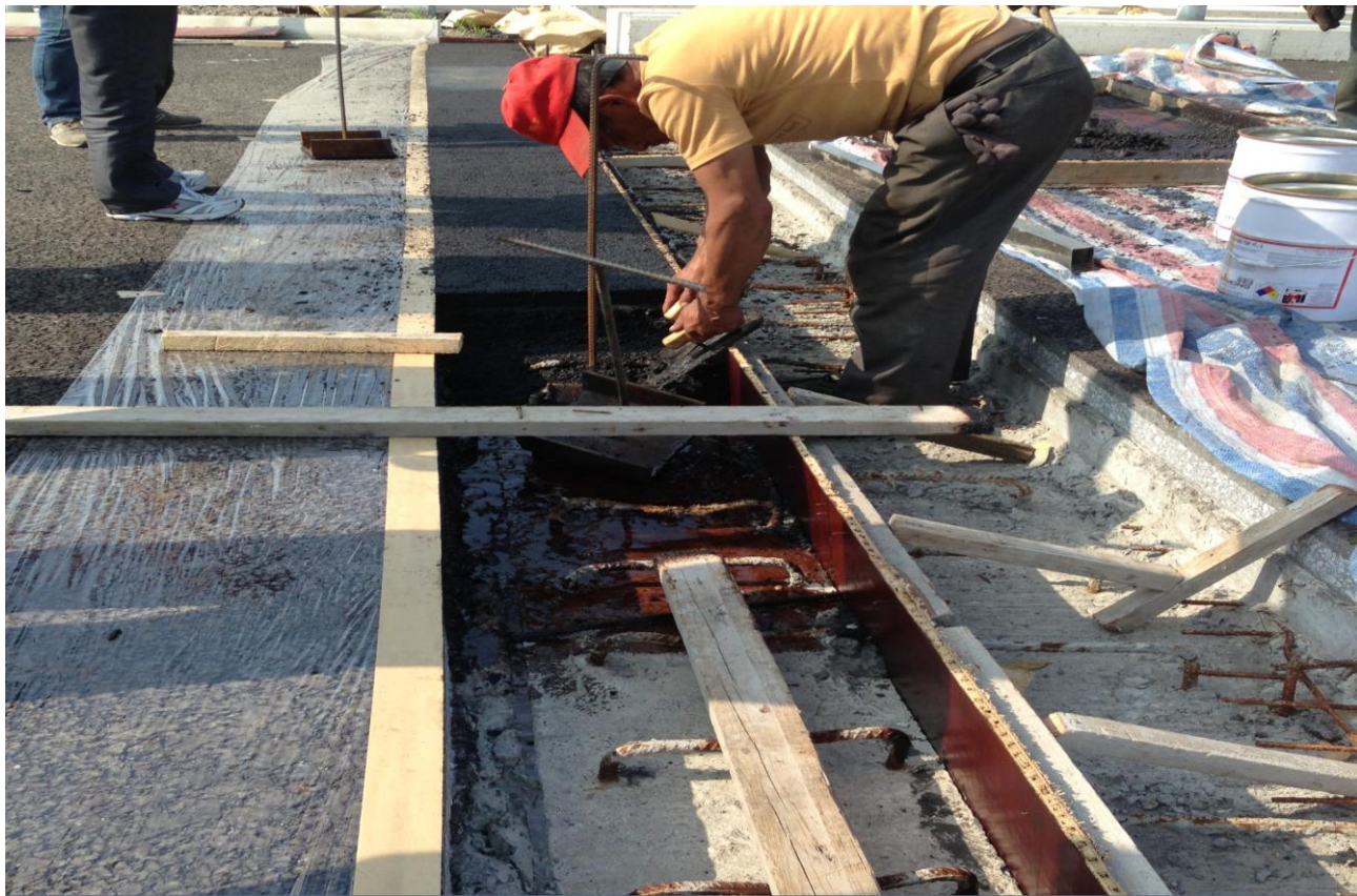
2、浇筑树脂混凝土
