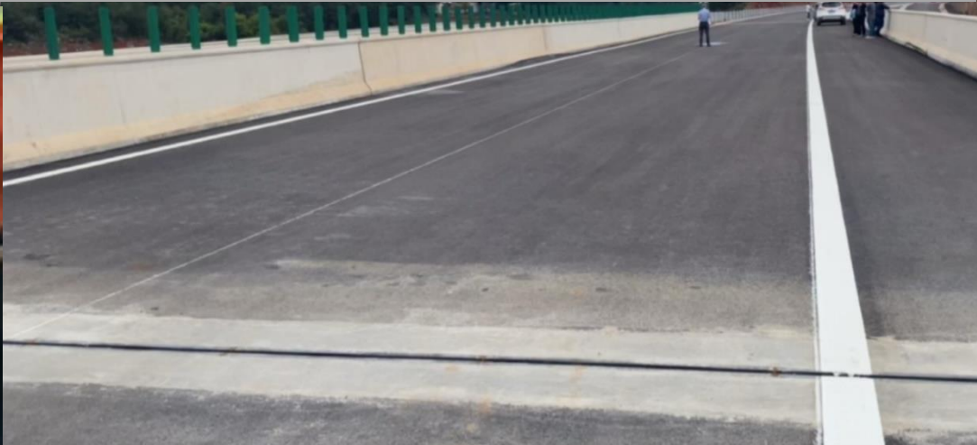
洒水养生、7-28天放行交通
