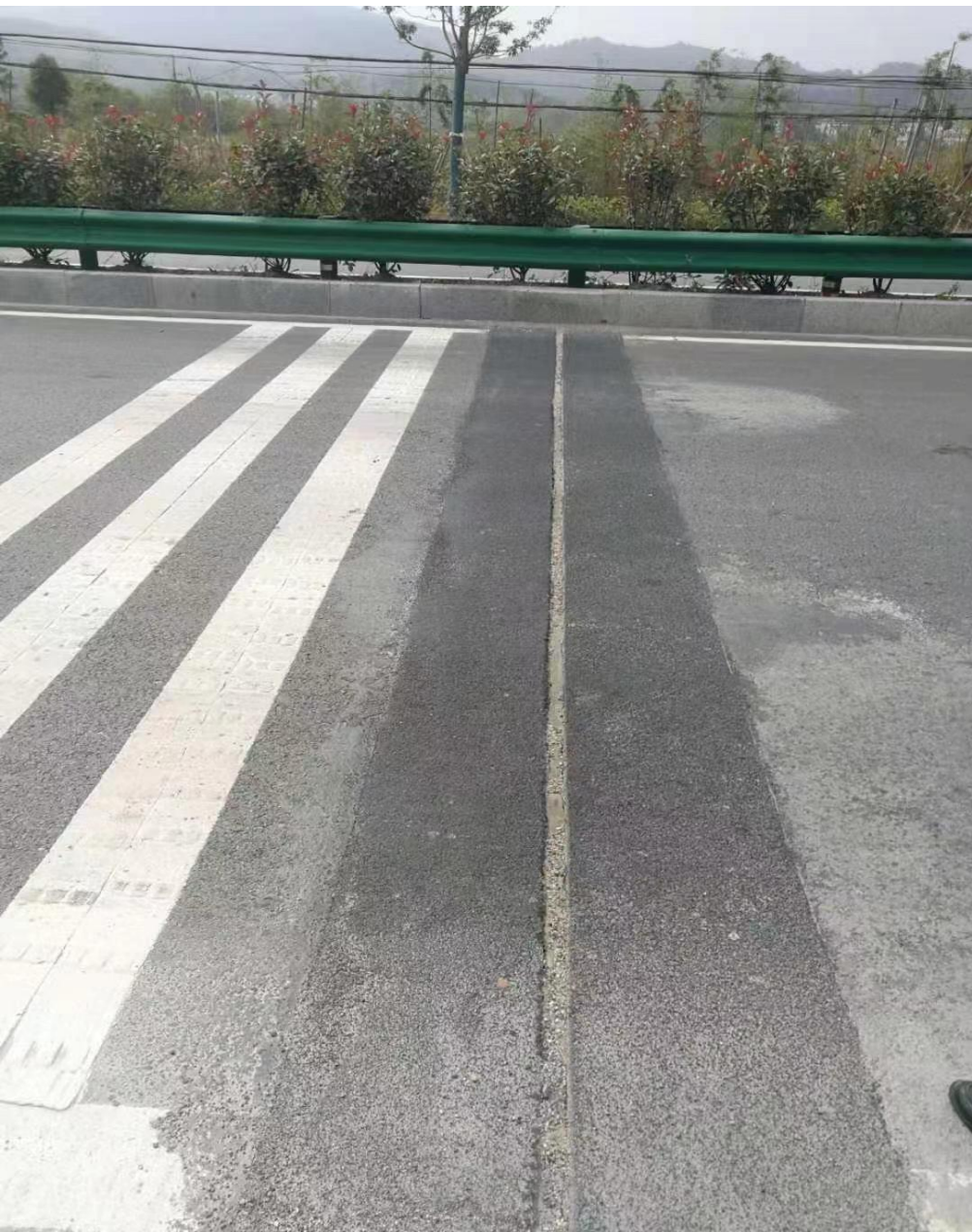
S108省道免型钢伸缩缝成型现场 三个月实拍
