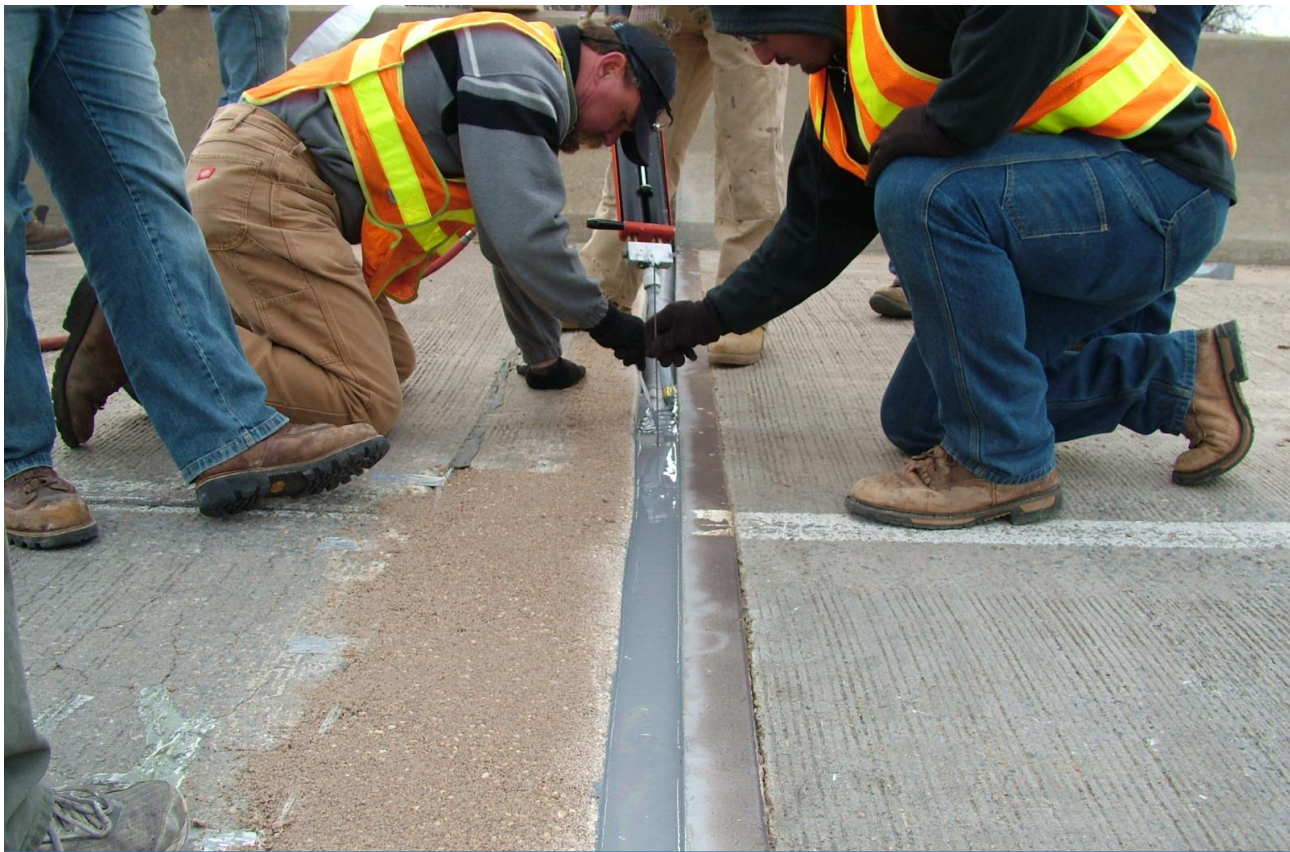
4、填缝、养护三小时成型
