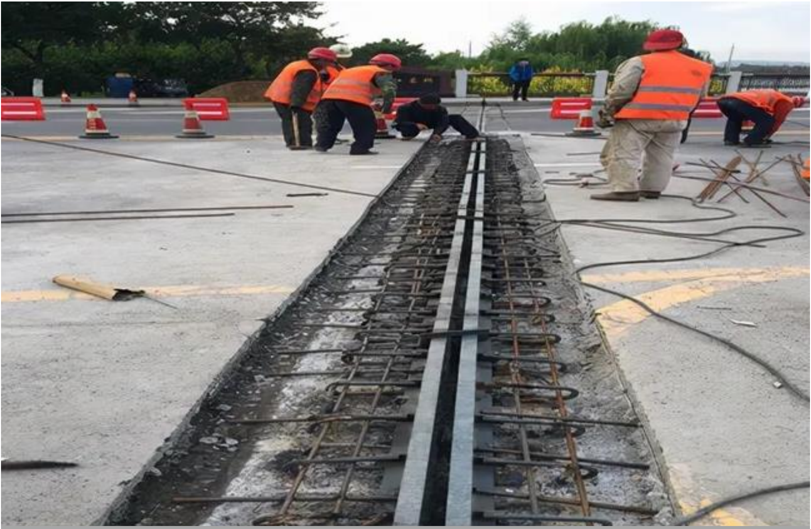
大面积拆除、修复或重新安装伸缩装置
