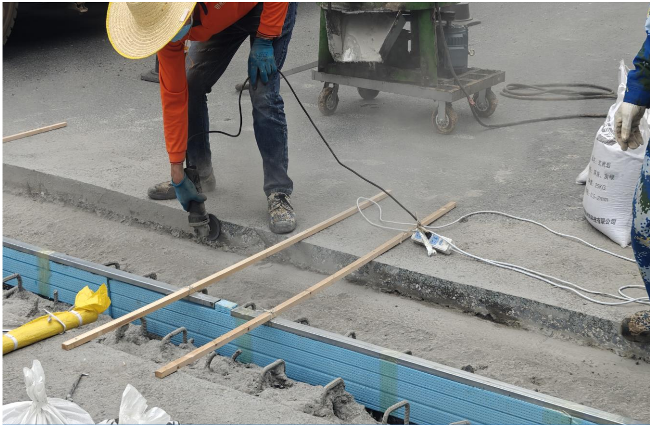
1、伸缩缝凹槽清理
