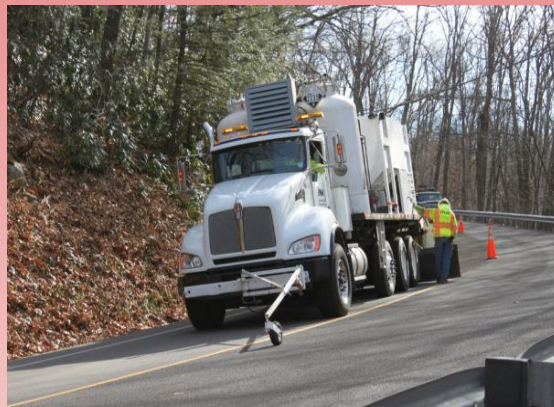
超薄高防滑罩面铺装 柔性聚合物混凝土
