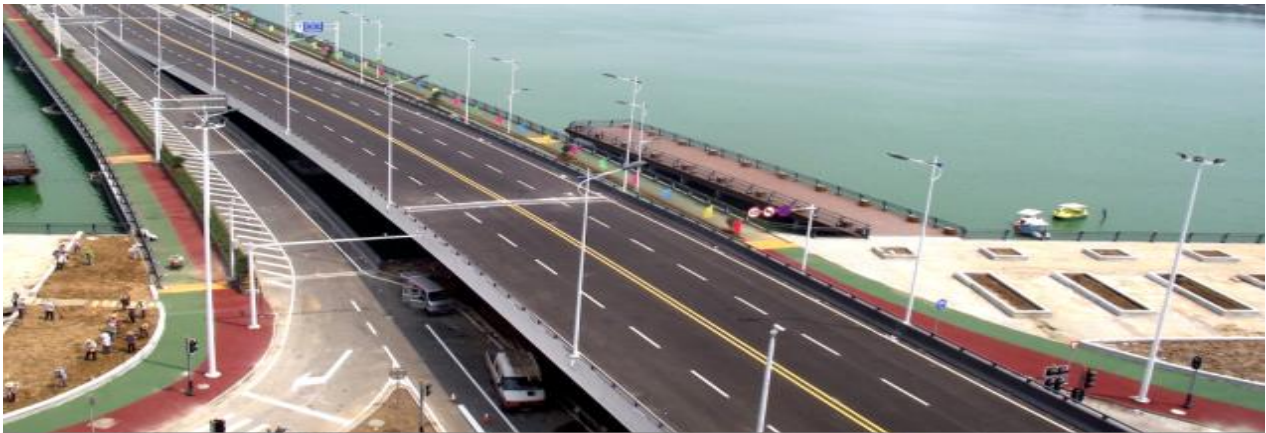
武汉市八一路延长线光谷大桥
