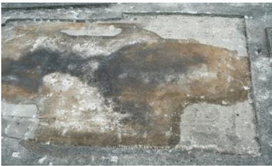
钢桥面板出现锈蚀
