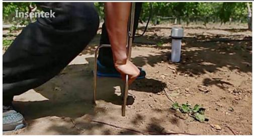
• ② 先安装太阳能板支架,再固定太阳能板。支架有两个方向地钉,两个地钉交替用力插入土壤。
