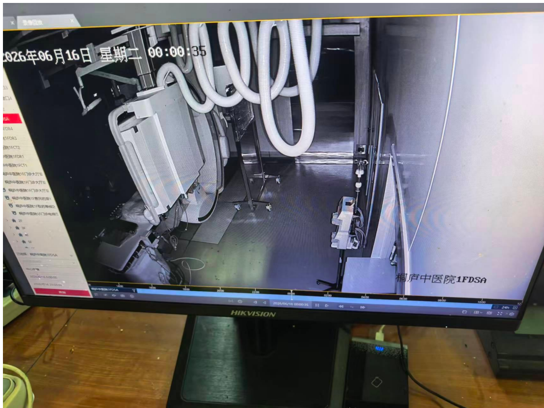
机房内监控摄像头及显示屏监控画面
