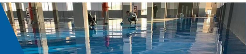
◆ 环氧树脂自流平型地坪是高级环氧树脂加优质固化剂良好的助剂制造而成，要求高度洁净、美观、无尘、无菌的电子、微电子行业、实行 GMP 标准的制药行业、血液制品行业、医院的百级移植间、百级至十万级区域的地坪涂装。
