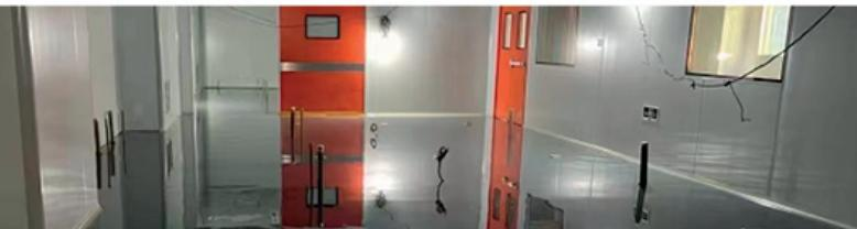
◆ 环氧树脂砂浆型地坪是采用环氧抗压耐磨砂浆与环氧面漆结合而成的高耐磨抗压地面，是专业解决重型机械制造企业厂房、工业及商业仓库、地下停车场等地面保护问题的地坪，该地坪具有极高的耐磨及耐冲击性。
